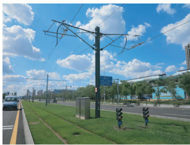
图1 浑南有轨电车信号系统正线轨旁设备
