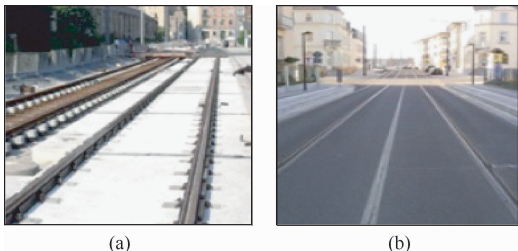
图4 满铺式现浇混凝土整体道床
