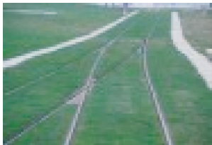
图3 CHN 50 kg/m 钢轨对称道岔
